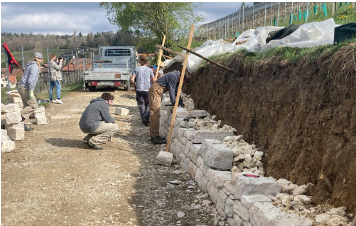
Die Zivi's des Vereins Naturnetz waren überaus motiviert beim Bau der Trockenmauer in Trüllikon am Werk. Entstanden ist ein Natur-Kunstwerk, das ökologisch hochwertigen Lebensraum bietet. © BirdLife Zürich
